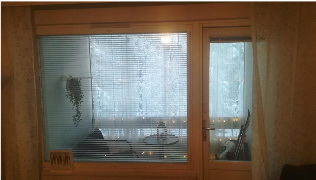
Kuva 2. Korvausilmaventtiili parvekkeen ikkunassa.
